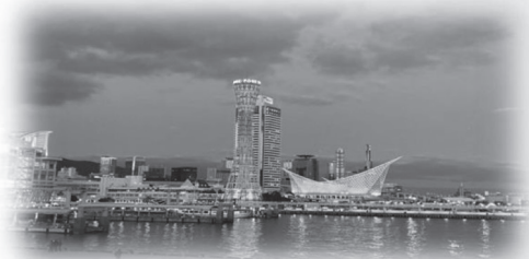
(ポートタワーのライトアップ)
